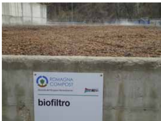
FIGURA 2 - Impianto di Cesena, biofiltro (by-courtesy of Herambiente Srl)
