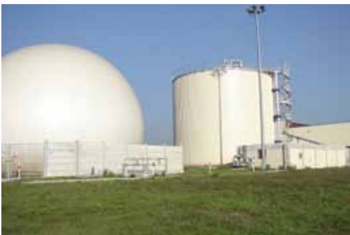
FIGURA 5 - Etra SpA, impianto di Camposampiero (PD) (by-courtesy of Etra SpA)
